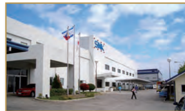
増築工事を完了したフィリピン工場
